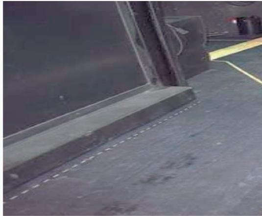
*Después del montaje, verificar la estanqueidad del telón cortafuegos*
